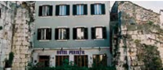
Hotel Peristil Split (Croazia)
